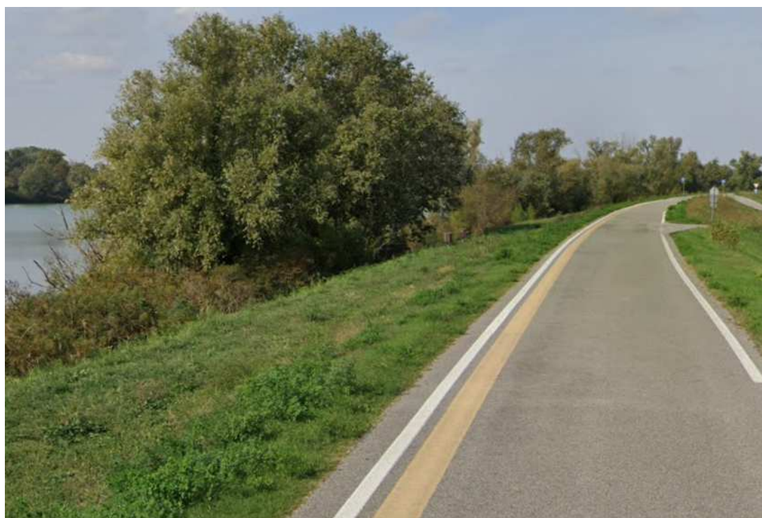
Figura 18: Foto 2 – A sinistra è individuabile il lato di argine su cui verrà installato il diaframma, a destra la strada di sommità arginale.
